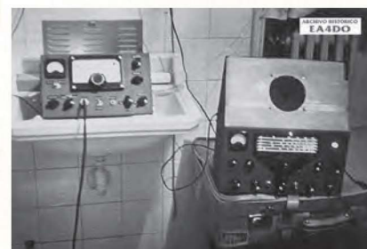
Estación portable de EA7HB, a mediados de los años cincuenta, compuesta de un receptor (sobre la maleta) y transmisor "El Chino", contruidos ambos por EA4DY.
